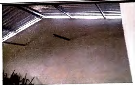
Foto 4: 100% de reparación de repollado de paredes dentro de cada una de las aulas.
