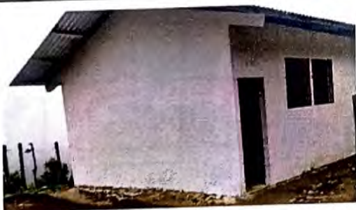
Foto 3: 100% de reparación de repellado de paredes de las afueras de cada una de las aulas.
