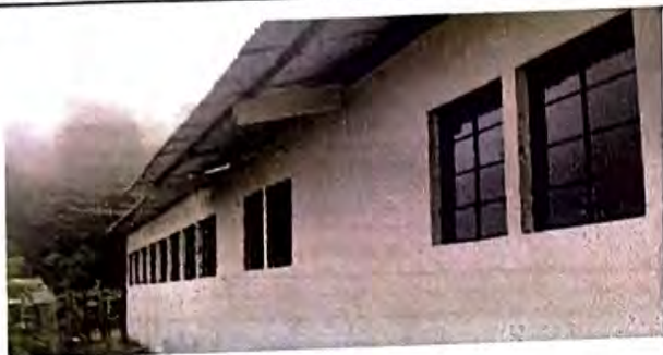
Foto 1: Llegó el 100 % de reparación de las ventanas de las aulas
